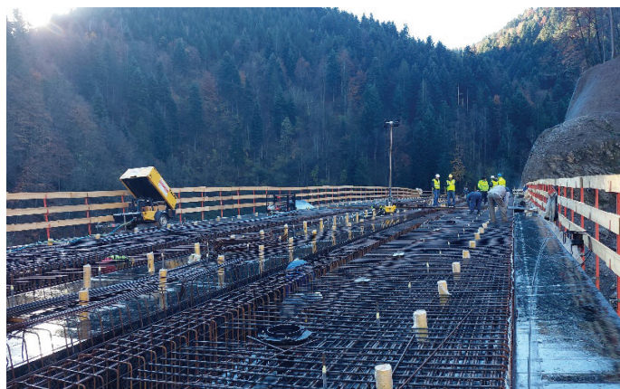
Sliki 12 in 13. Opaženje in polaganje armature prekladne konstrukcije mostu (Foto: Karolina Korenčan).
