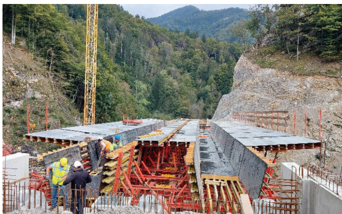
Sliki 12 in 13. Opaženje in polaganje armature prekladne konstrukcije mostu (Foto: Karolina Korenčan).
