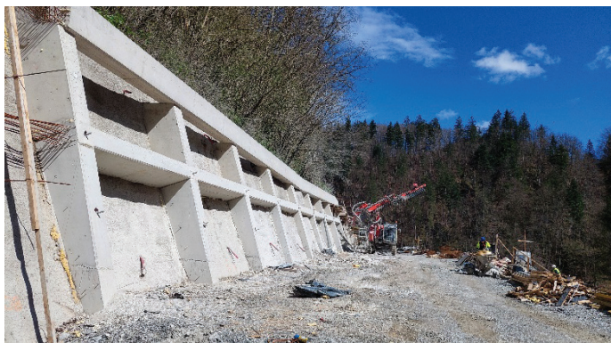
Slika 19. AB-slopi in grede kot oporni ukrep (Foto: Karolina Korenčan).
