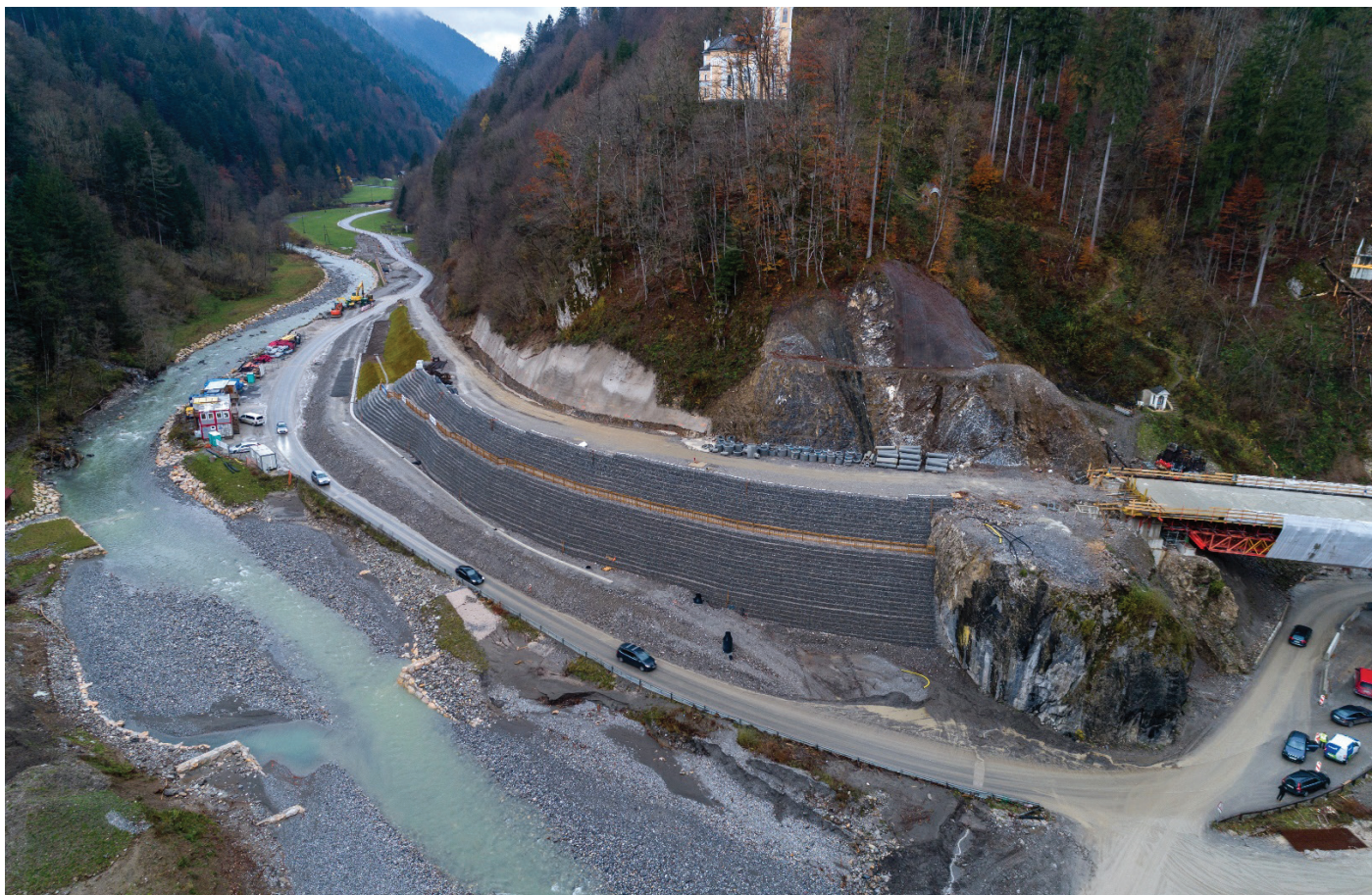
Slika 18. Prestavitev regionalne ceste, vrezane v strmo skalno pobočje (Foto: Andrej Tarfila).
