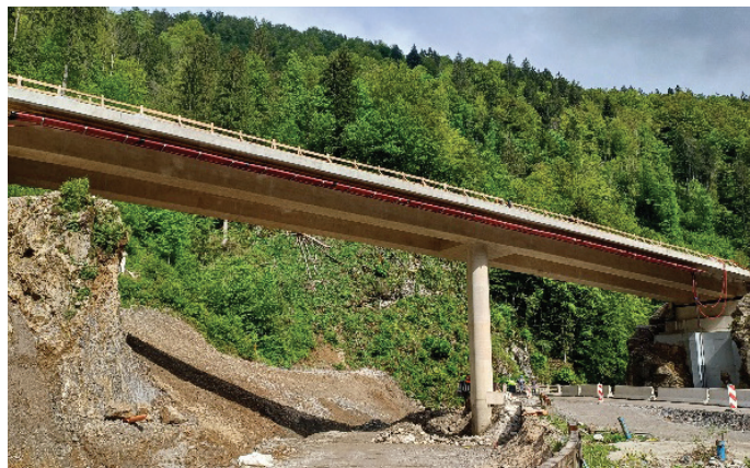
Slika 15. Pogled na most (Foto: Amir Pjanić).
